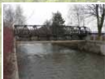
poklopný jez na 36,8 km
