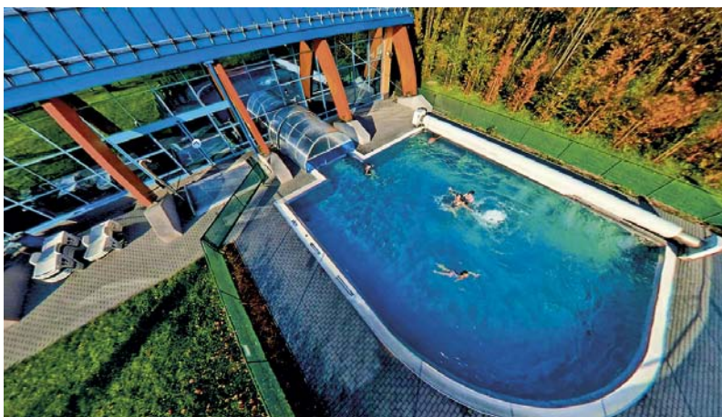
Aquacentrum – průplavový bazén
