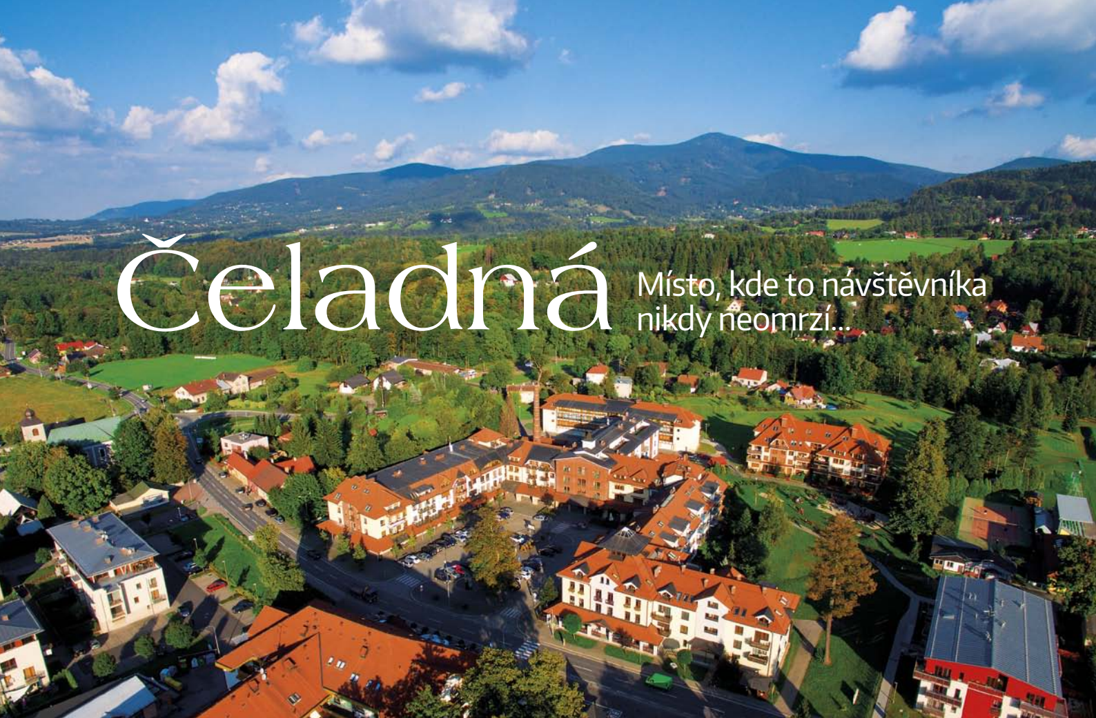
Čeladná – střed obce, foto: m-ARK
